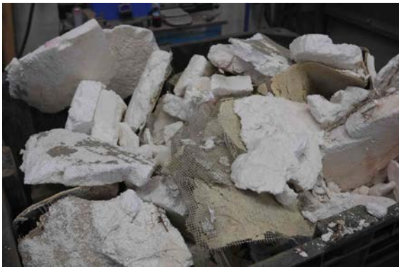
EPSolutely_Probenmaterial_maschinellem_Rückbau_WDVS.jpg © Fraunhofer Austria
